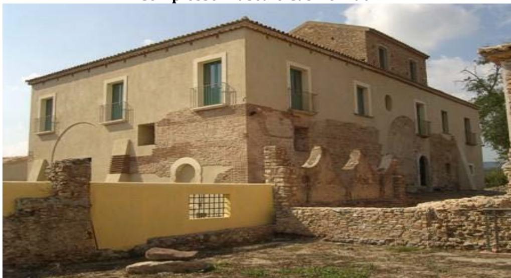
Esterno del Casino Macrì, dove è possibile vedere parte della vecchia costruzione romana
